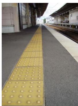
【味鋤駅（着手前：点状ブロックのみ）】
